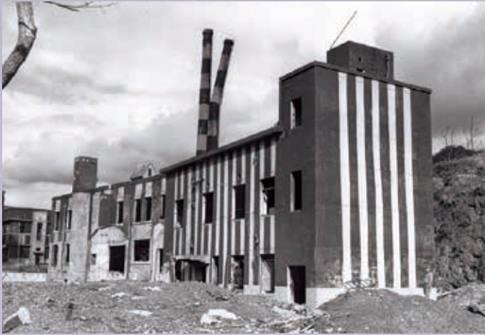
長崎医科大学附属医院の調理部厨房棟。黄色の化粧しつくい仕上げの上に黒の塗料を塗って偽装している。遠くからは灰色に見え、背後の丘陵と混じりあって見えにくくなることを期待したと思われる。
